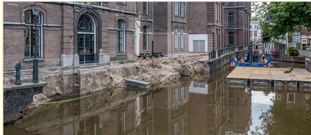
Figuur 9. Kademuur Grimborgwal (Fotograaf: Alphons Nieuwenhuis, 02.09.2020)
